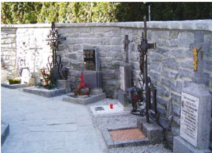
Die neue Friedhofsmauer in Tumpen.
