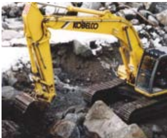
Mit Natursteinen wurden entlang der Ache die schützenden Dämme errichtet
