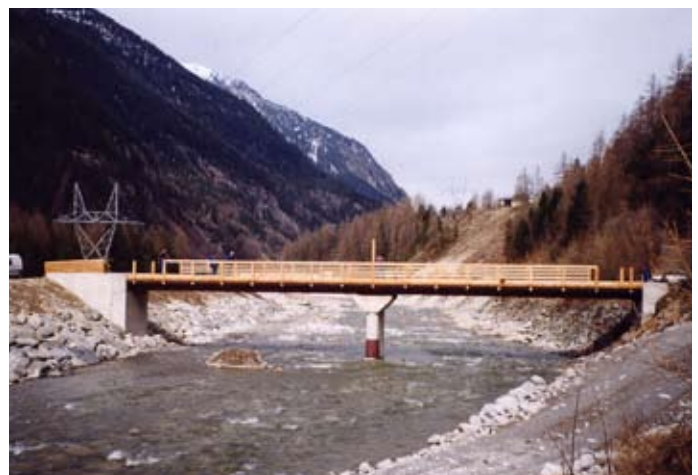
Die neu errichtete Fundusbrücke
