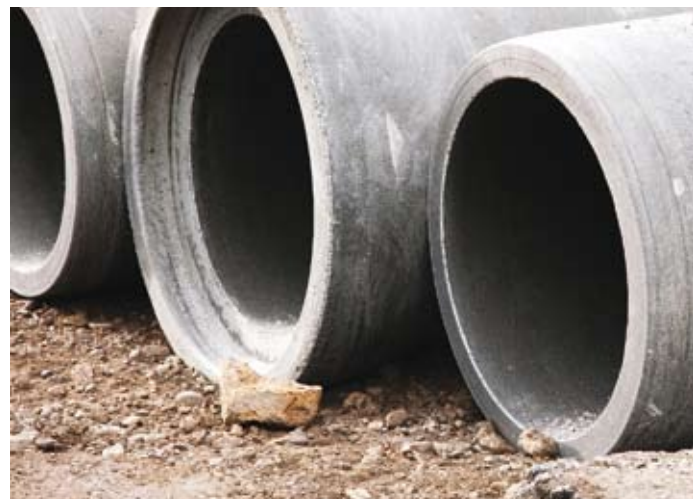
Kanalrohre neben der Straße findet man in Umhausen nicht mehr
