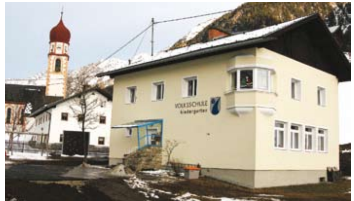
Schule und Kindergarten wurden komplett saniert
