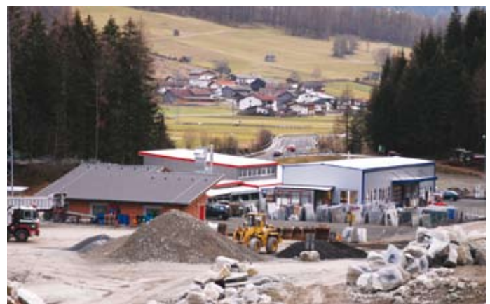
In Tumpen entsteht ein neues leistungsstarkes Gewerbegebiet
